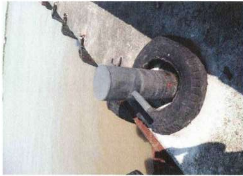
ภาพแสดงกันกระแทกและหลักผูกเรือสภาพดี แข็งแรง
