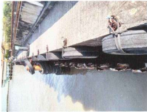
ภาพแสดง หน้าทำที่แข็งแรงไม่มีรอยแตกร้า ไม่ทรุดเอียง
