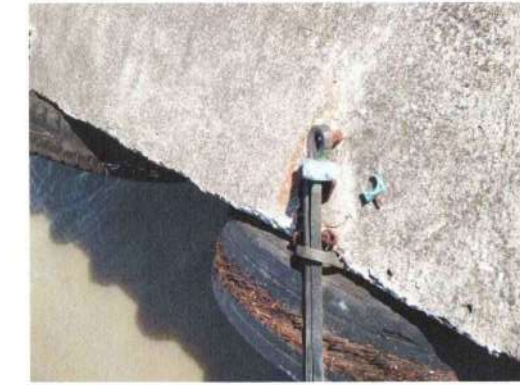
ภาพแสดง หน้าทำที่แข็งแรงไม่มีรอยแตกร้า ไม่ทรุดเอียง
