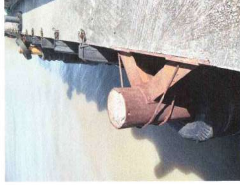
ภาพแสดง หน้าทำที่แข็งแรงไม่มีรอยแตกร้าว ไม่ทุดเรียง
